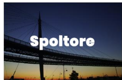
Abruzzo: sede di riferimento Strada Statale 16bis, 86 – 65010 Spoltore (PE)
